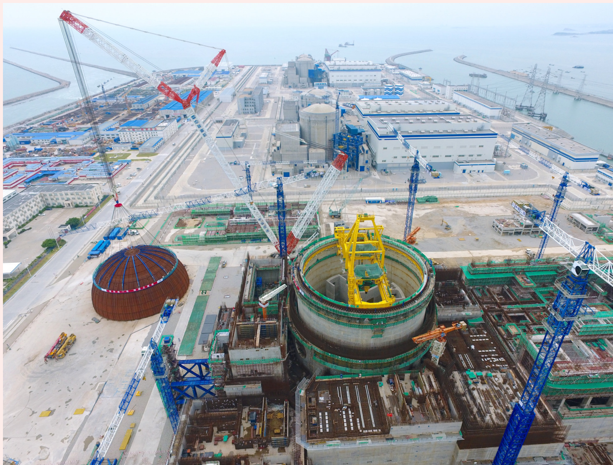
中国自主研发三代核电技术“华龙一号”全球首堆示范工程——福清核电站5号机组吸引着全球目光。这座代表中国制造业先进水平的机组已按期完成多个节点工程，“华龙一号”将由此走向世界。 (姜克红 摄)
