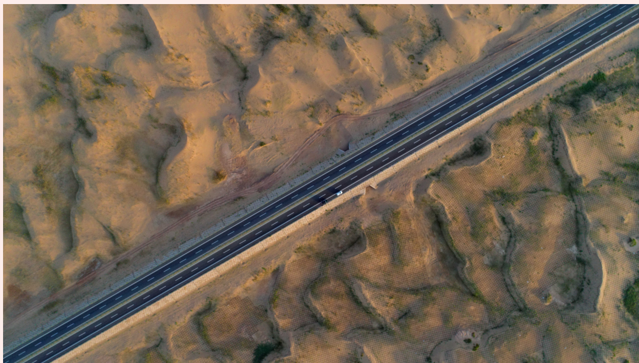
北京到新疆全线高速公路贯通使新疆至北京的公路里程缩短 1000 多公里。图为京新高速临白段内蒙古巴彦淖尔境内，道路一侧是防沙网格。（邓华 摄）
