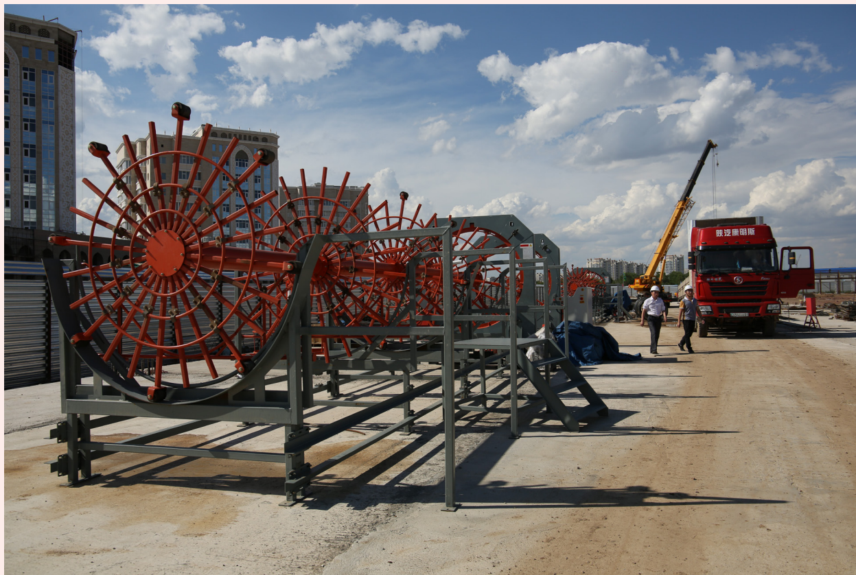
建设中的阿斯塔纳轻轨是哈萨克斯坦首条城市轻轨，项目采用中国规范设计施工并由中国企业承建。（奥斯帕诺夫 摄）
